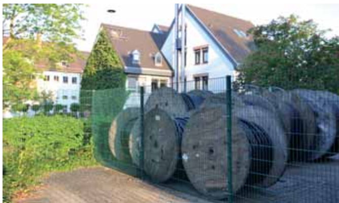
Die Kabeltrommeln mit den Glasfaserleerrohren warten auf ihre Verwendung.
