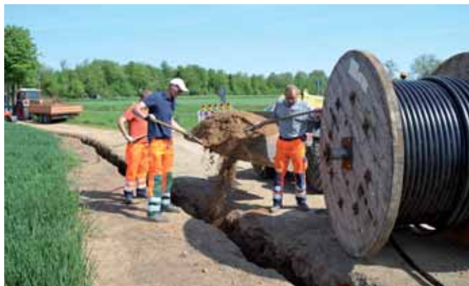
Mitarbeiter des städtischen Bauhofs erstellen in Eigenleistung den Graben zur Verlegung der Leerrohre bis zur Anschlussstelle.
